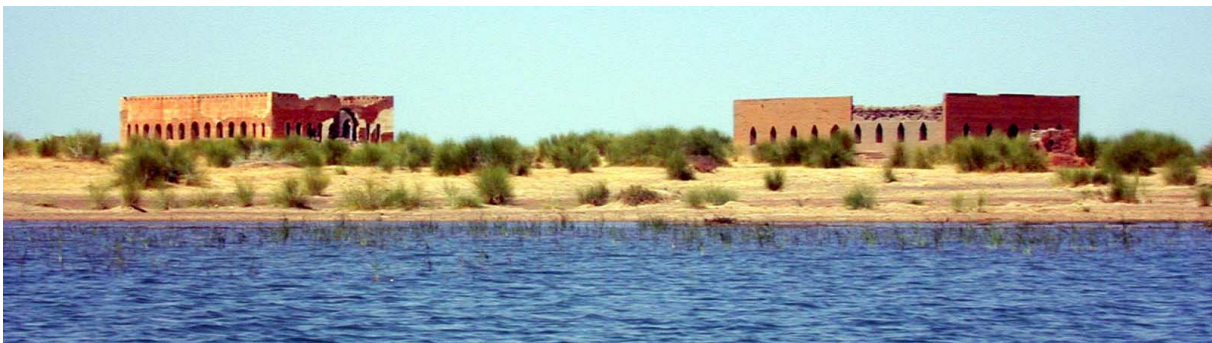
Bild 3: halbverfallene Verwaltungsgebäude aus der Kolonialzeit
