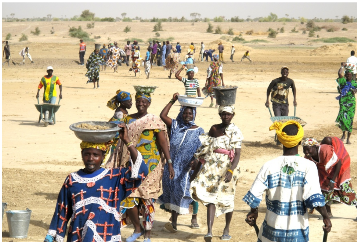
aménagement d'un périmètre irrigué villageois à Youmaïra, secteur Bara Issa, février 2010
