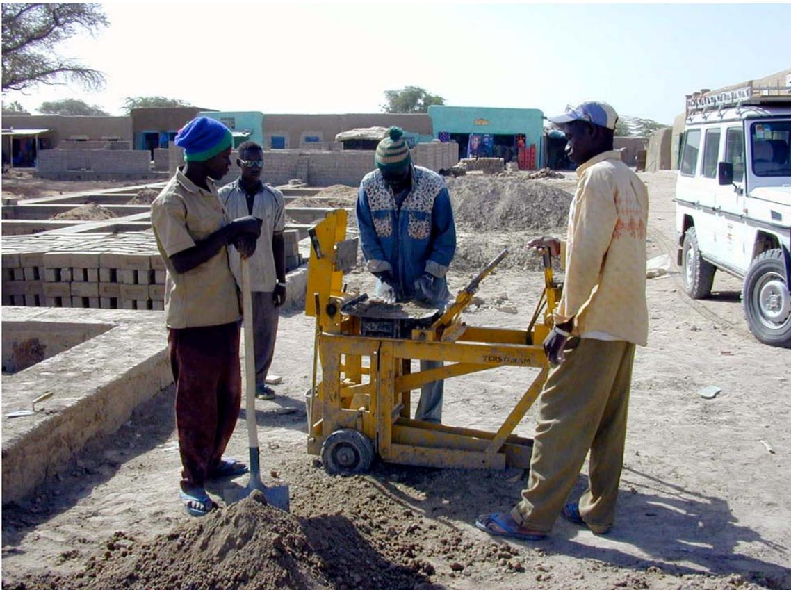
Photo 1 : production de briques stabilisées en banco (Léré)
