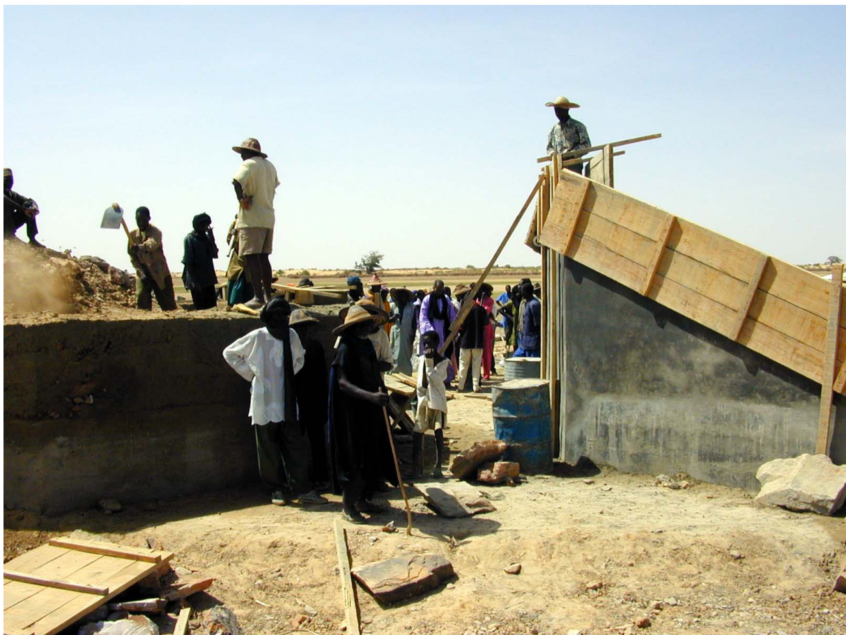
Arbeit am Einlaßbauwerk
