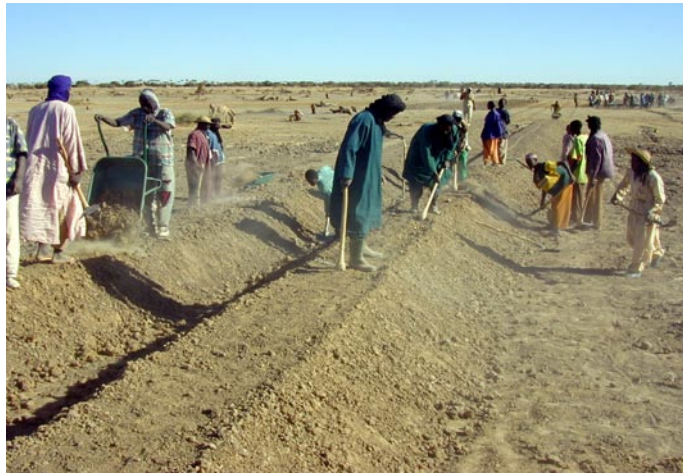
aufschuetten eines bewässerungskanals
